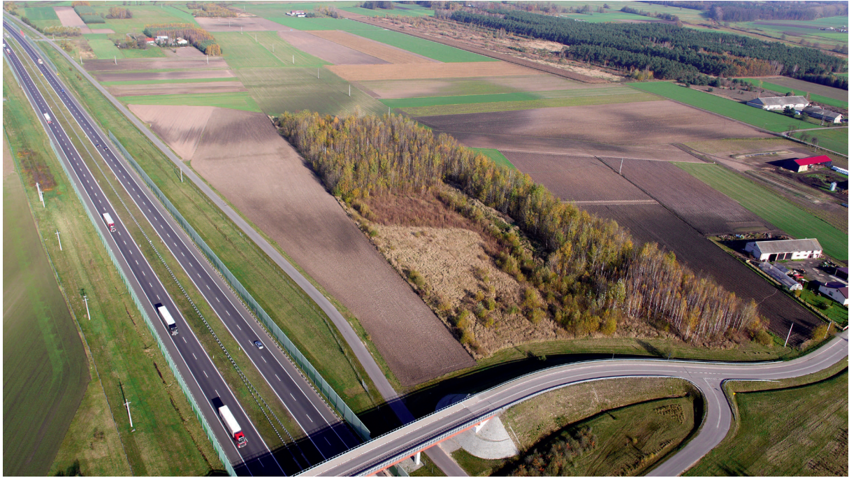
Ryc. 2. Rogaszyn, gm. Piątek. Widok na stanowisko w 2022 r. od strony południowej.
